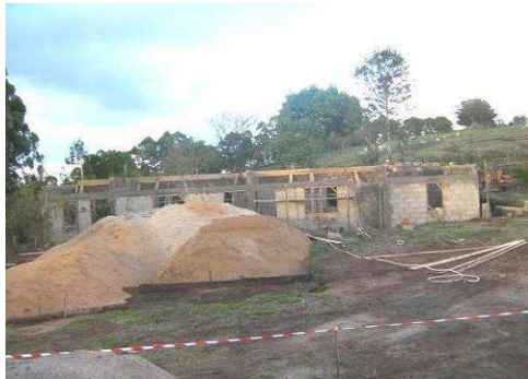
Bau des Schulungsgebäudes
